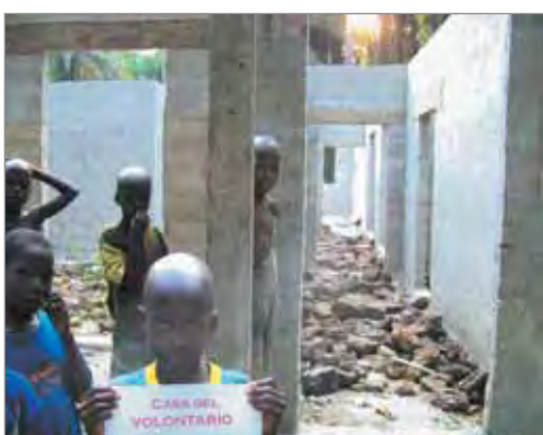
Interno della Casa del volontario a Lokomasama
