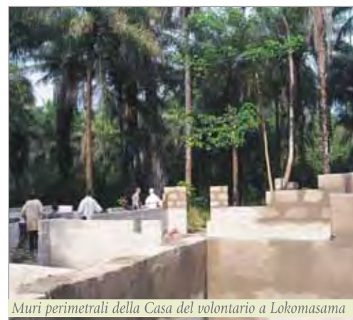
Inizio dei lavori del Centro medico - Maggio 2008
